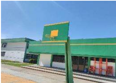
Cambio de tableros
