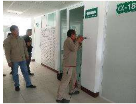
Colocación de extintores
