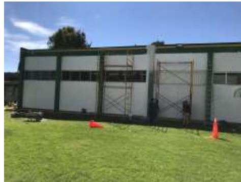
Edificio K Laboratorio de Ciencias de la Tierra
