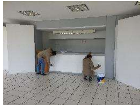
Aplicación de pintura
