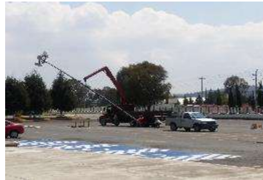
Mantenimiento a lámparas exteriores
