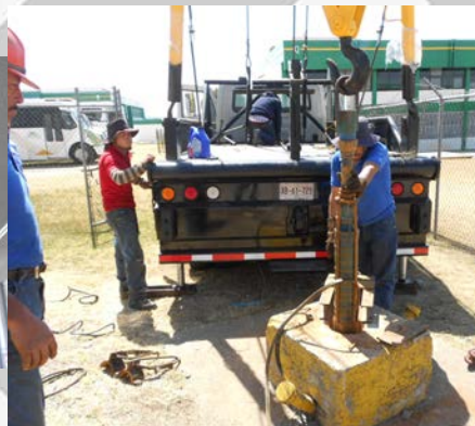
Mantenimiento a bomba
