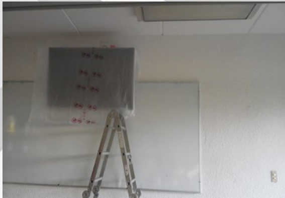
INSTALACIÓN DE PANTALLAS LG 55 PULGADAS
