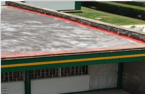
Chaflán Edificio "I"
