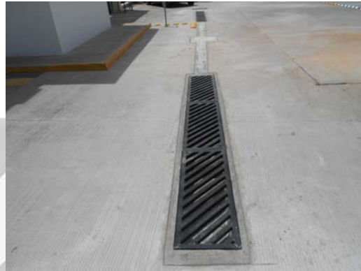
Trincheras pluviales
