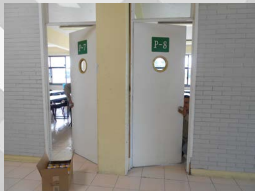
Mantenimiento a cerrajería
