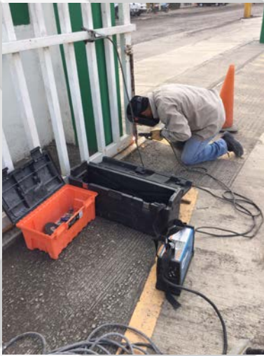
Soldadura de rejas
