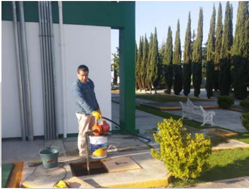
Mantenimiento a registros
