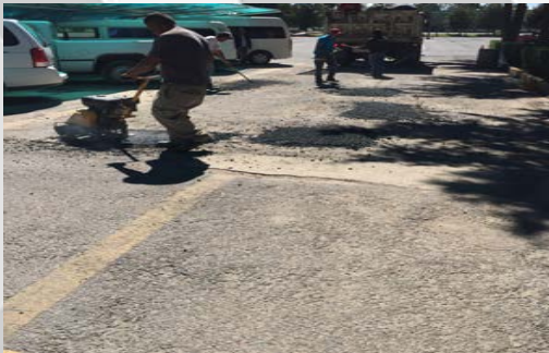
Bacheo a estacionamiento
