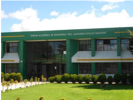
Rotulación de faldones
