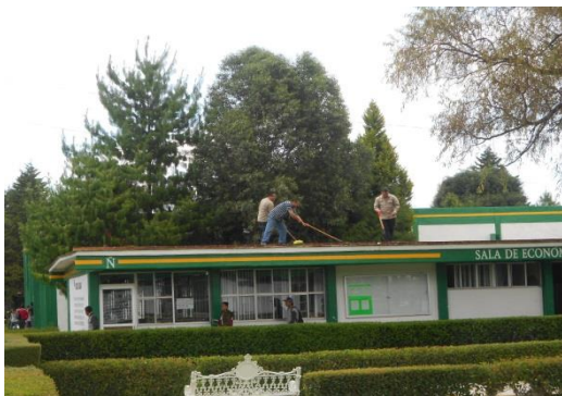
Limpieza de azoteas
