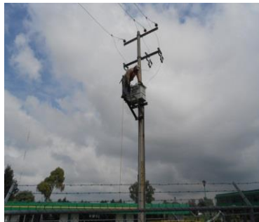
Mantenimiento a transformador
