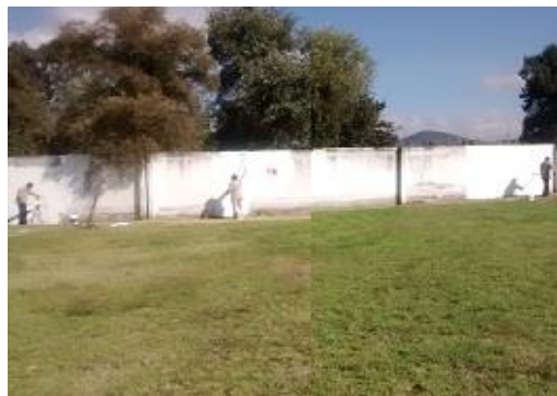
Mantenimiento a barda perimetral norte
