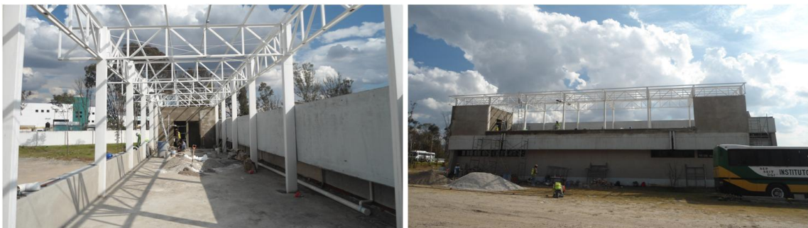
Construcción de Gimnasio de acondicionamiento físico
