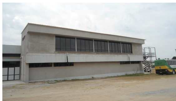
Gimnasio de acondicionamiento físico al 95% de avance.
