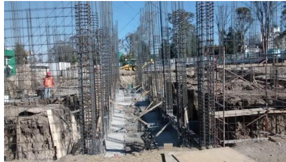
Inicio de construcción de la Unidad de Posgrado y Cuerpos Académicos.
